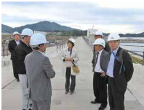
陸前高田市の防潮堤の建設現場にて
