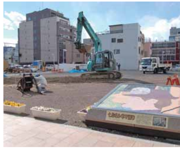
水道庁舎建設予定地
