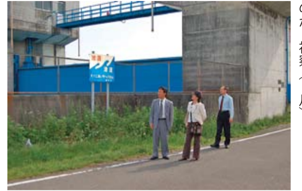
駿河区の浜川水門（津波想定6m）は想定外の津波に耐えられるのか、視察（5月）
