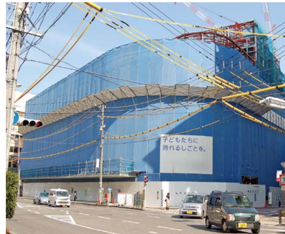
23年秋オープンにむけて建設中の新静岡センター
