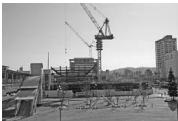
PFI方式で建設中の清水文化施設
