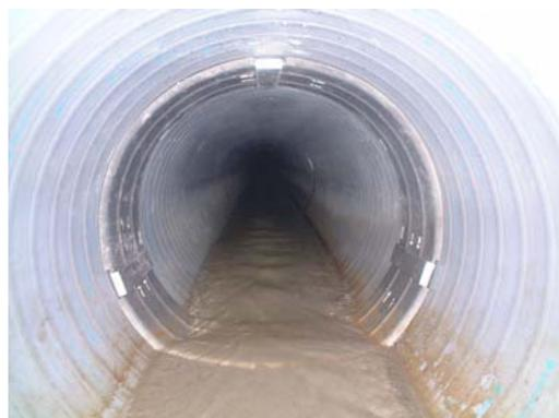
耐震補強した下水道管(施工事例)
