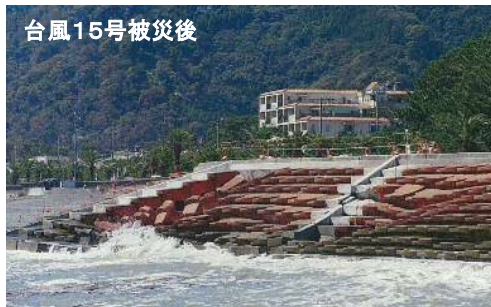
用宗漁港緩傾斜護岸
