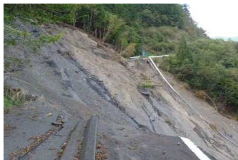
(主)南アルプス公園線
