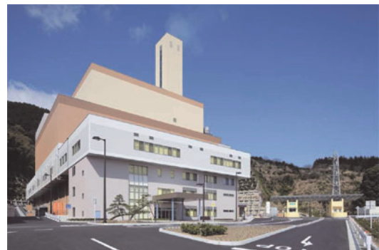
2010年3月から運転をはじめた 西ヶ谷新清掃工場
