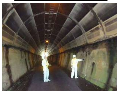
トンネル点検の様子
