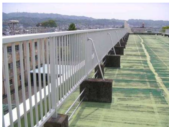
校舎屋上への転落防止柵設置例(清水小学校)
