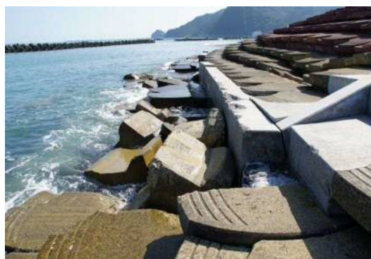
用宗漁港緩傾斜護岸
