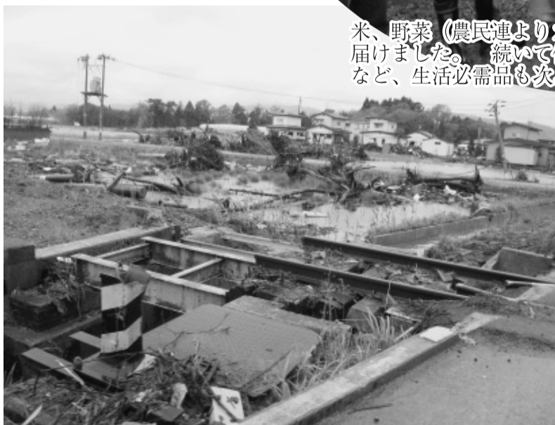
常磐線の線路も押し流す津波の凄まじい破壊力
